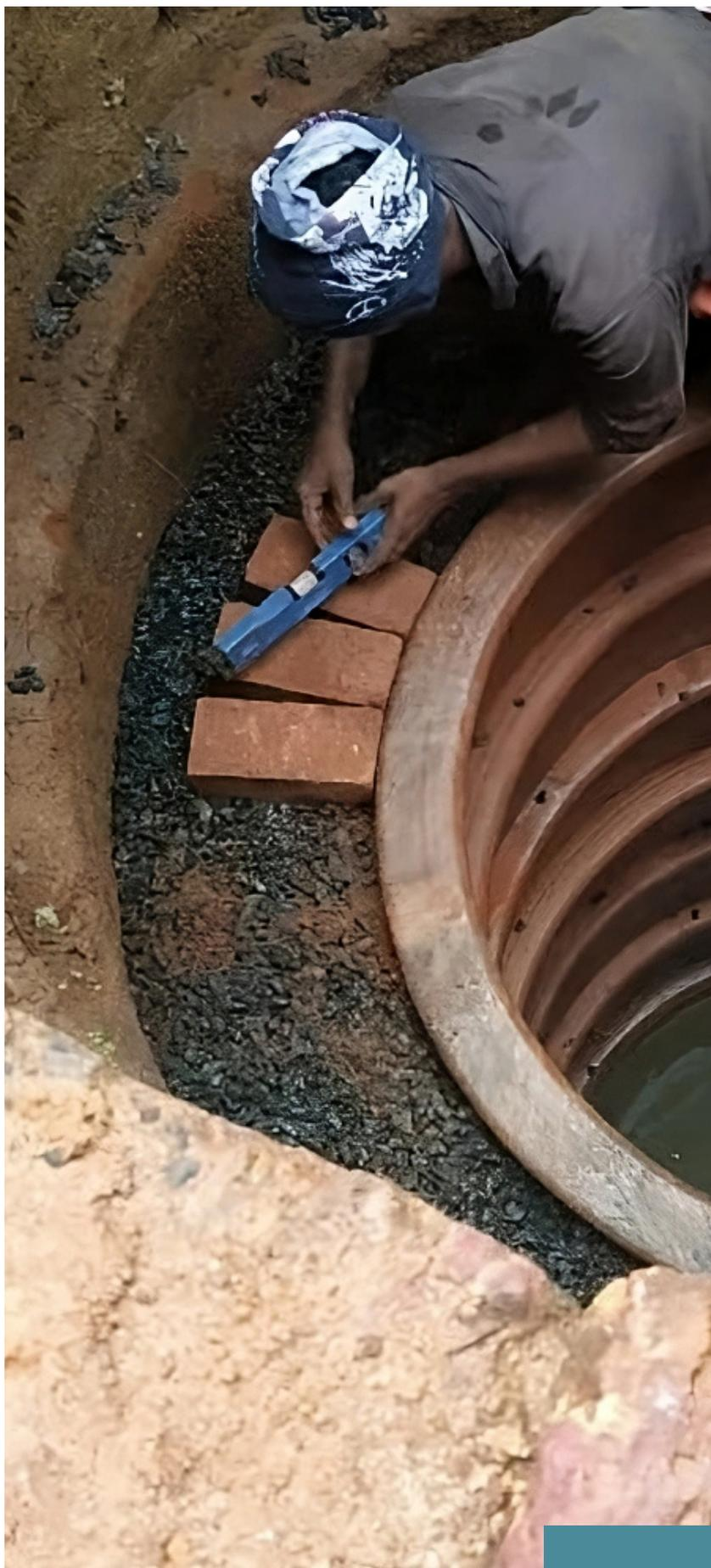
Couvage de puits avec des anneaux d'argile en Inde. ©KK Clay Works
