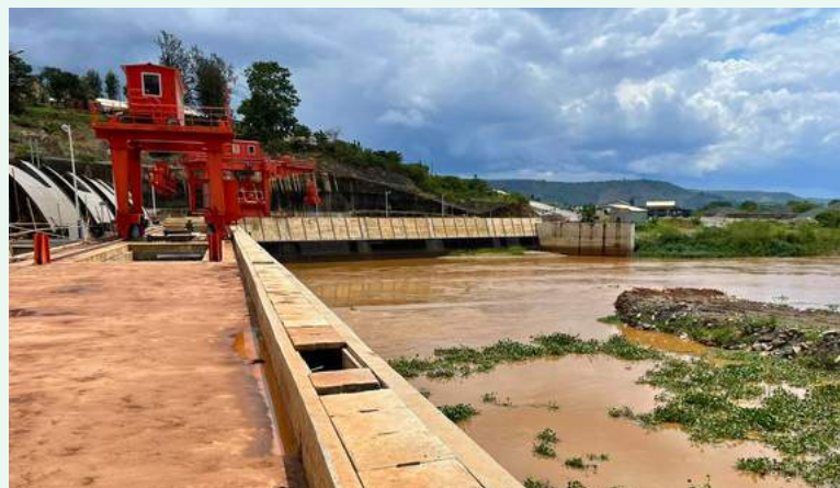
Projet hydroélectrique régional des chutes de Rusumo (Rwanda). ©Anders Jagerskog/CIWA
